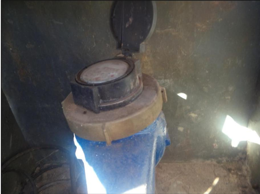
**Foto 05:** hidrômetro instalado no Poço Tubular
