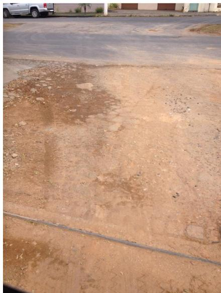
Fotos 3 e 4: imostra a entrada no estabelecimento: água de chuva passa por baixo da guia do portão, mostrando que pode levar areia e brita para área externa. Na foto 4 observa-se nitidamente a calçada e a via de trânsito recebendo areia do depósito.
