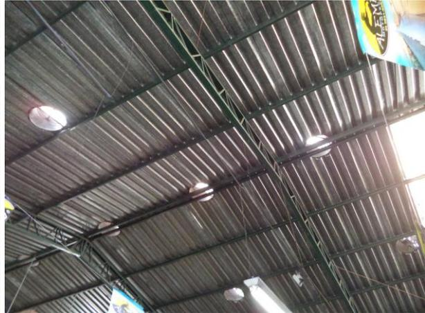
**Figura 14:** Telhado metálico com exaustores de ar
