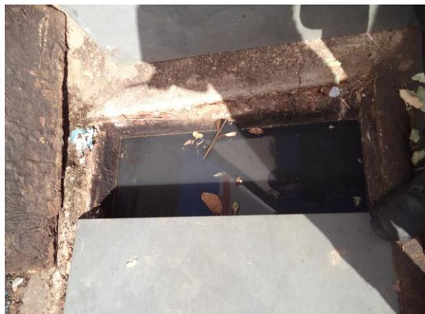
**Figuras 17 e 18:** Caixa separadora de água e óleo – observar compartimentos cheios
