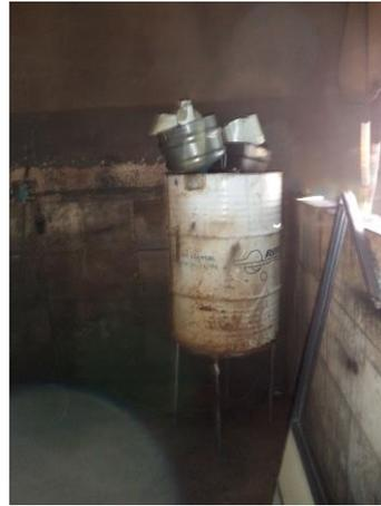
**Figura 08:** Tambor utilizado para guardar efluentes oleosos
