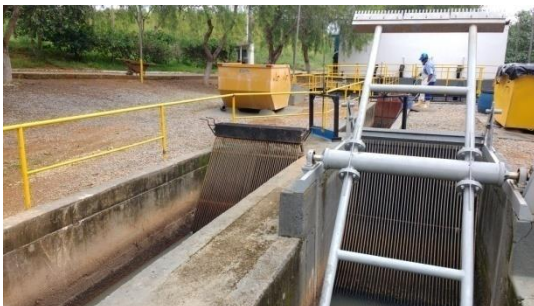
Foto 04: Detalhe de um rastelo rotativo - gradeamento mecanizado no TP
