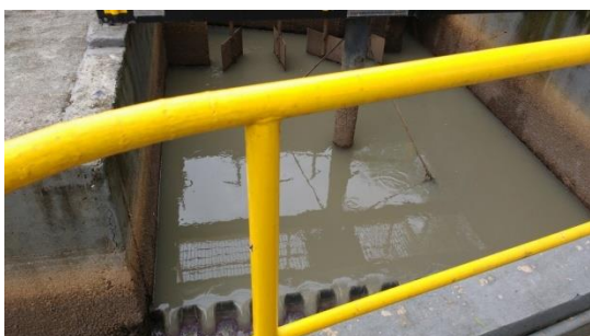
Foto 07: Vertedouros de saída na caixa de areia.
