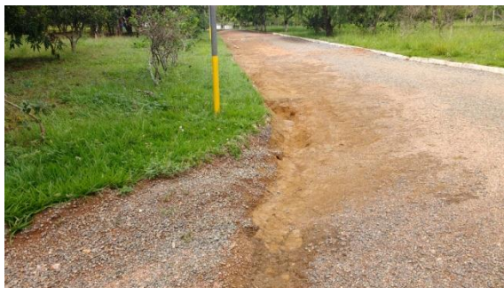
Foto 29 e Foto 30: Processos erosivos ocorridos devido as obras do loteamento Jardins Mônaco – à montante da área da ETE.
