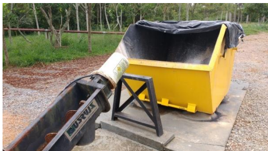
Foto 05: Desarenador tipo rosca helicoidal
