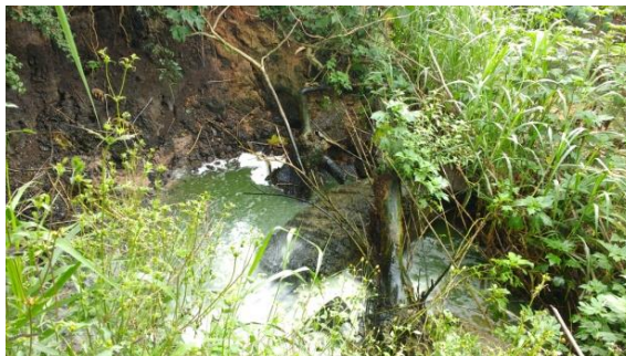
Foto 16: Erosão no ponto de lançamento do
