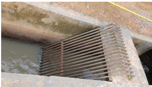
Foto 02: detalhe do gradeamento no TP
