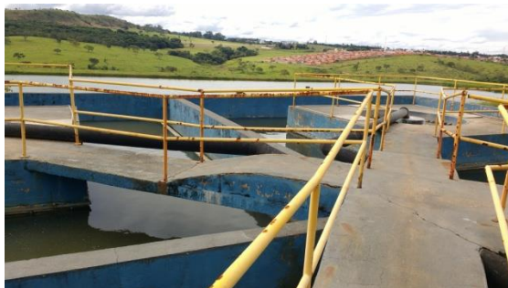
Foto 22: Reatores UASB e passagem para
