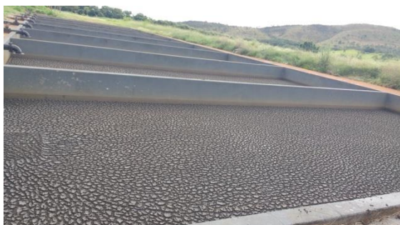
Foto 27: Detalhe dos leitos de secagem
