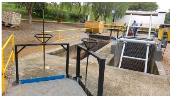
Foto 03: A frente: caixa de distribuição no TP - ver comportas para controle de fluxo.
