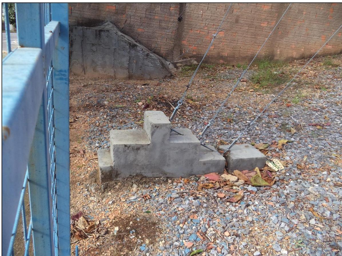
**Fotos 03:** Base de sustentação, detalhe nos cabos de fixação.
