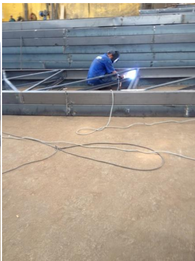
Foto 14: estrutura em execução
