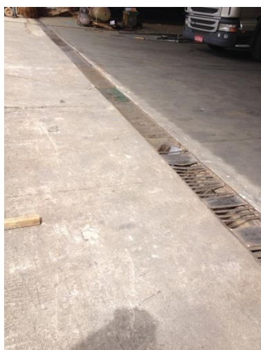
Fotos 7 e 8: grelha na entrada do galpão – pontas de solda e resíduos metálicos.
