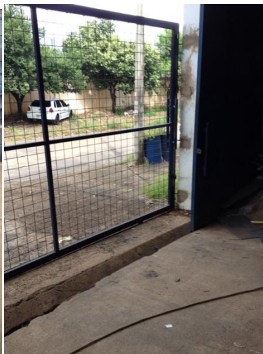
Foto 15: portão lateral: ventilação
