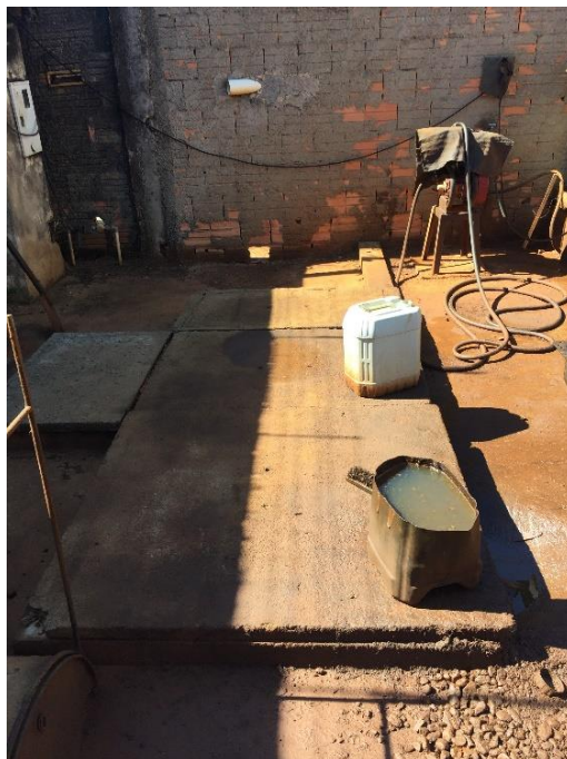
Foto 02: Caixa separadora de água e óleo
