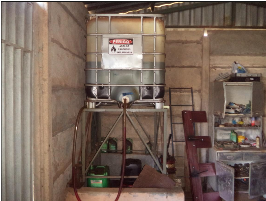
Foto 07: Ponto de abastecimento.
