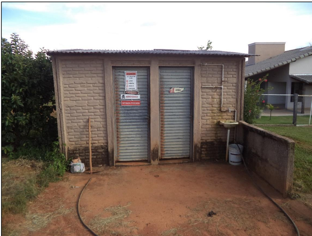
Foto 05: Galpão de agrotóxico.
