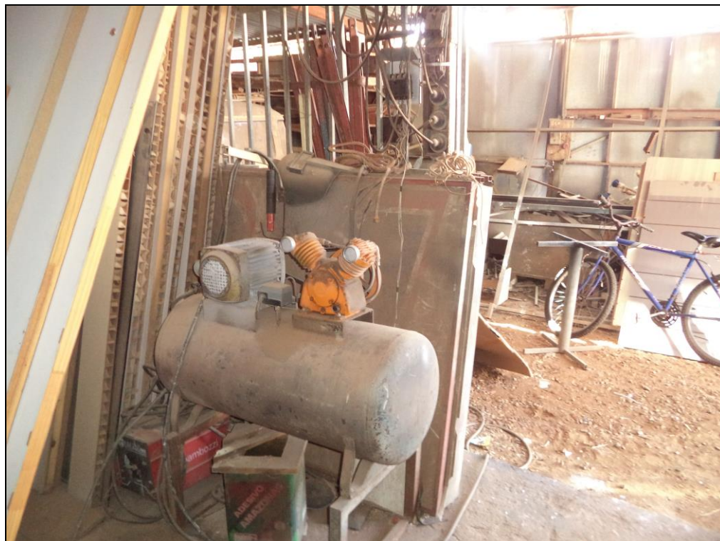
Figura 6 - Compressor de ar
