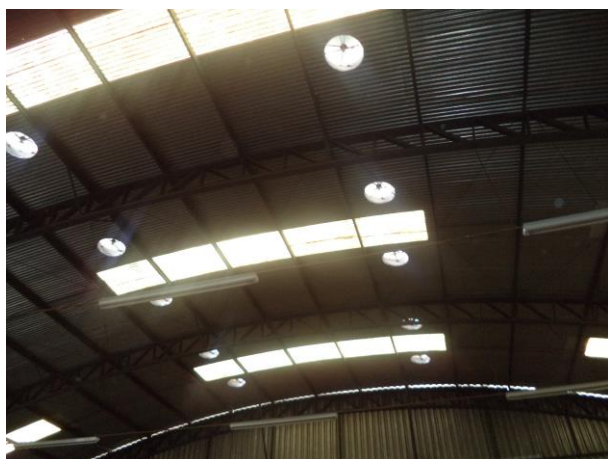
Figura 09: Teto metálico com telhas translúcidas e exaustores de ar
