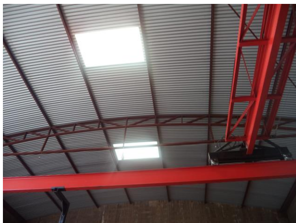
Figura 09: Telhado com telhas translúcidas
