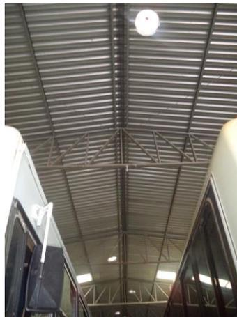
Figura 14: Observar o teto do barracão com telhas translúcidas e exaustores
