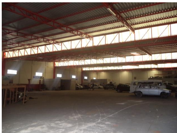
Figura 03: Vista do barracão de trabalho
