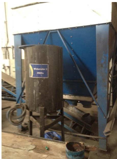
Foto 12: Planta de granulados que foi desativada.
