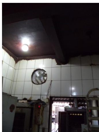
Figura 21: Exaustor de ar da cozinha
