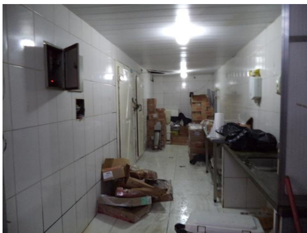
Figura 11: Corredor em frente às câmaras frias
