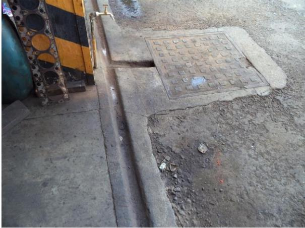
**Figura 03:** Canaleta e caixa de captação de efluentes contaminados com óleo/graxa
