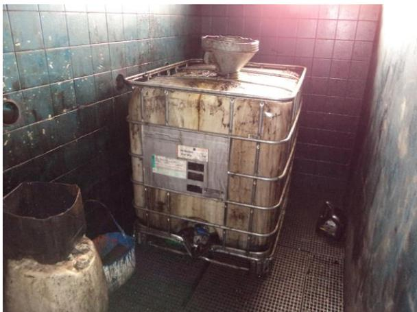
**Figura 07:** Tanque de armazenagem de efluente oleoso proveniente da CSAO
