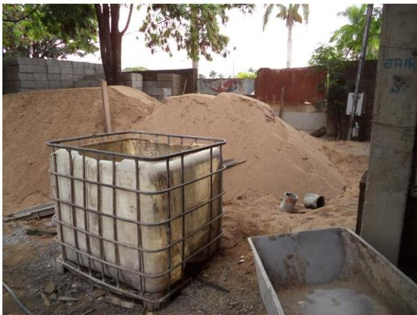
**Figura 05:** Recipiente de coleta de água pluvial
