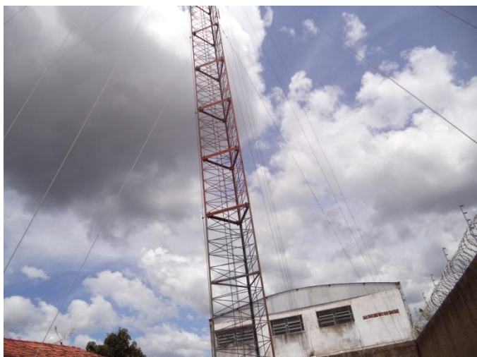
Fotos 03 e 04: Antena sustentada por cabos de aço e base onde os cabos de aço são fixados
