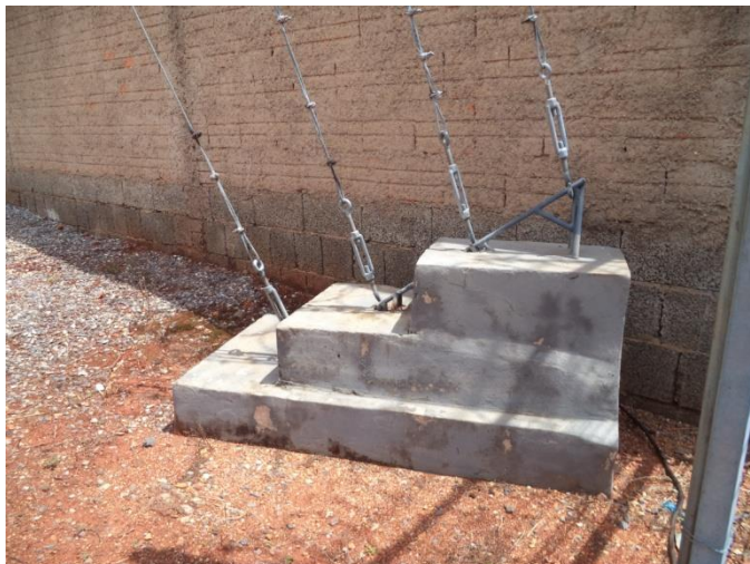
Fotos 03 e 04: Antena sustentada por cabos de aço e base onde os cabos de aço são fixados
