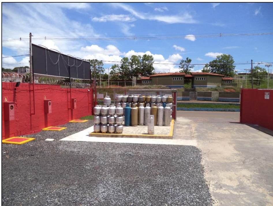
Foto 01: Vista da área de armazenamento dos botijões
