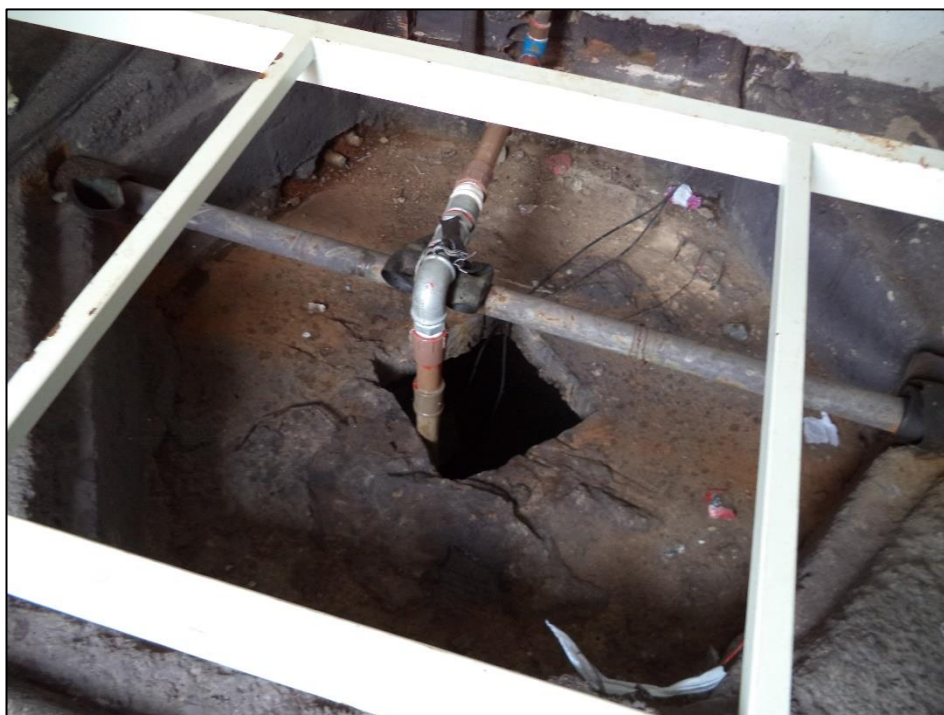
Foto 04: Vista da cisterna utilizado no empreendimento
