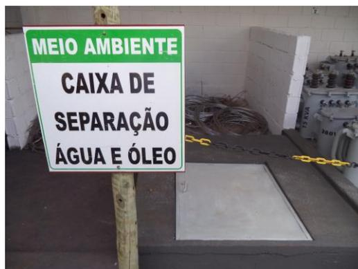
Figura 10: Caixa de retenção de óleo na baia de contenção de transformadores
