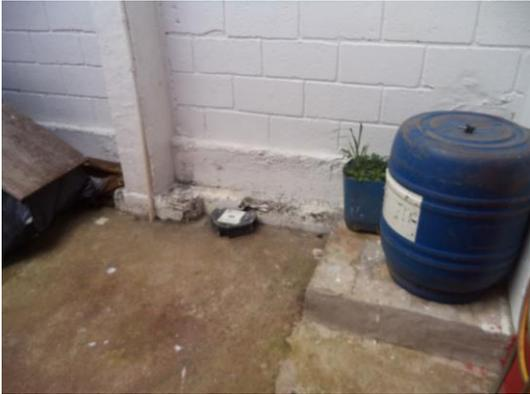
Figura 11: caixa externa de passagem de água pluvial coletada do telhado
