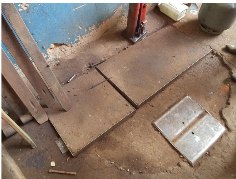
Figura 3: Caixa separadora de água e óleo
