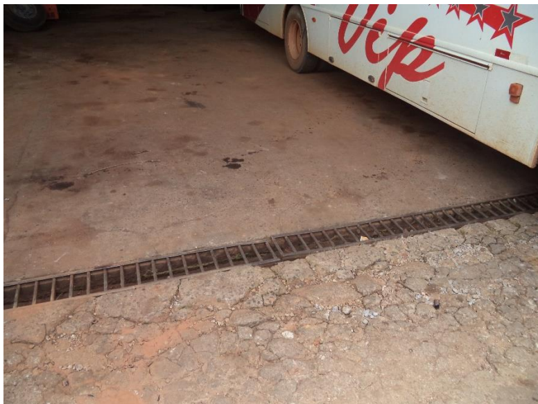
Figura 2: Canaletas de contenção
