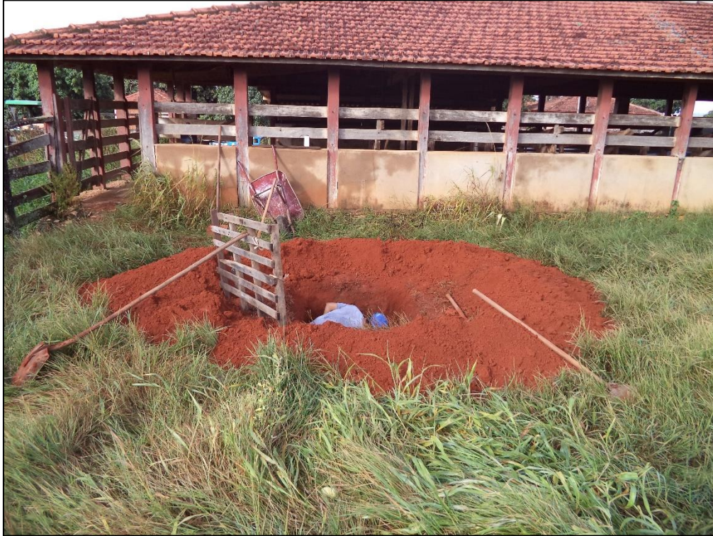
Foto 2: Vista da fossa séptica em construção.
