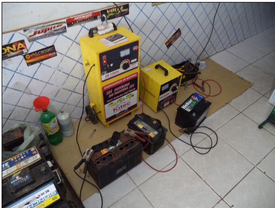
Foto 03: Carregador de baterias.
