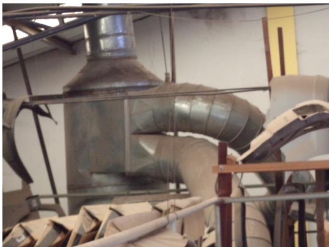
Fotos 03 e 04: Coifa da cabine de pintura e depósito de peças
