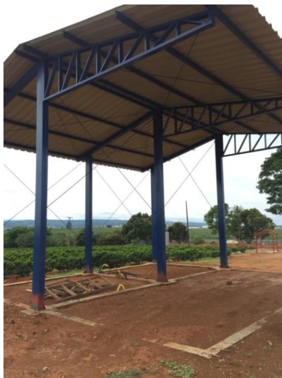
Foto 07: Posto de abastecimento em construção.
