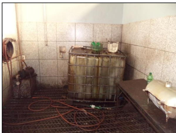
Foto 05: Lavador e tambor de armazenamento de óleo usado
