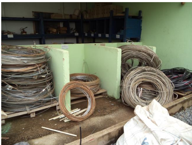
Figura 06: Cabos de eletrificação
