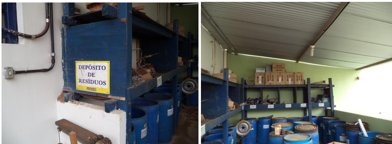
Figura 03 e 04: Galpão de depósitos de resíduos sólidos
