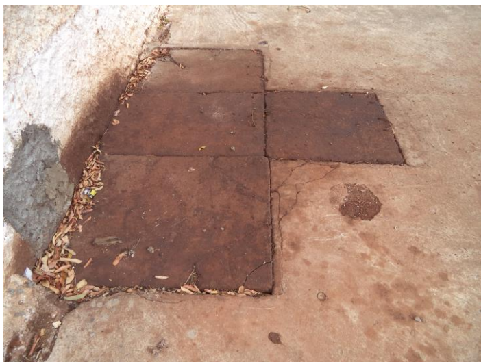
Figura 07: Caixa separadora de água e óleo
