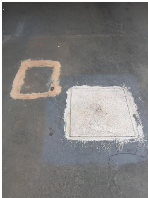
Foto 9: caixa de gordura do estabelecimento
