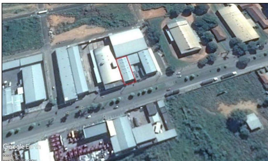
Figura 1: Vista aérea do empreendimento. (Fonte: Google Earth 2017).
