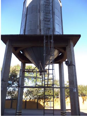
**Figura 35:** Silo para carregamento dos caminhões, a granel
