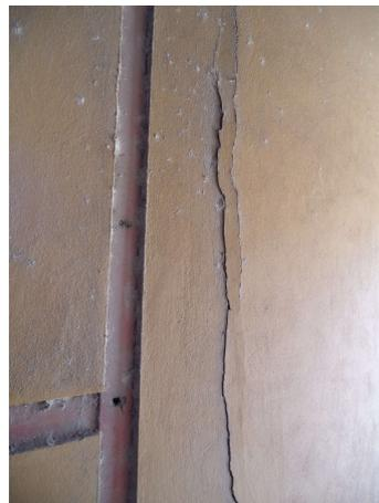
**Figura 33:** Rachadura na fornalha devido ao calor
