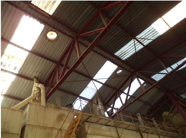
**Figura 09:** Vista parcial do telhado do galpão da fábrica de rações, mostrando as telhas translúcidas e exaustores de ar
