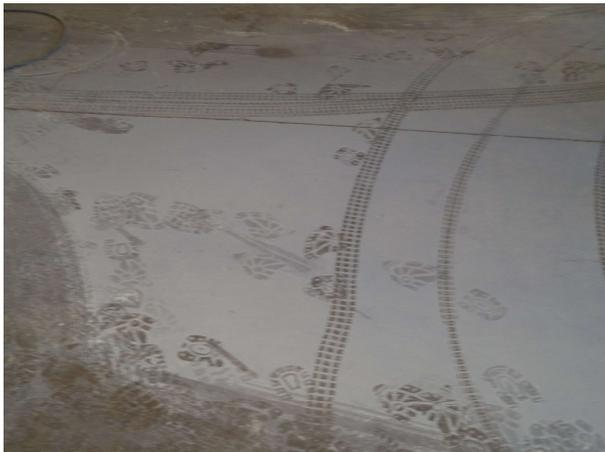
**Figura 11:** Vista parcial do piso da fábrica, com acúmulo de particulados
