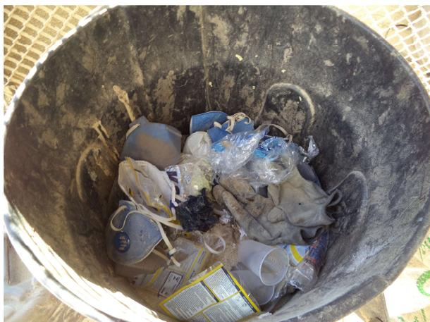
**Figura 23:** Descarte de EPI's usados
