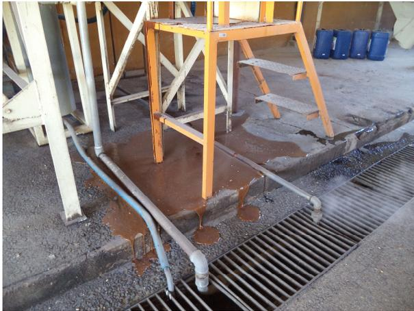
**Figura 15:** Melaço que transborda do tanque e vai para canaleta direcionada à rede pluvial
