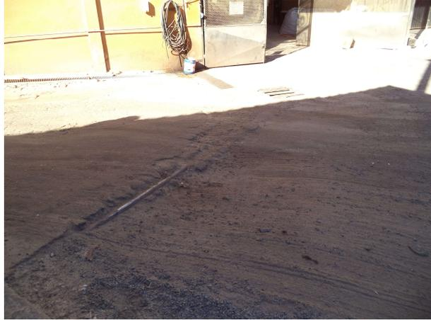
**Figura 20:** Encanamento que provém da caldeira e direciona os efluentes desta para a rede pluvial
