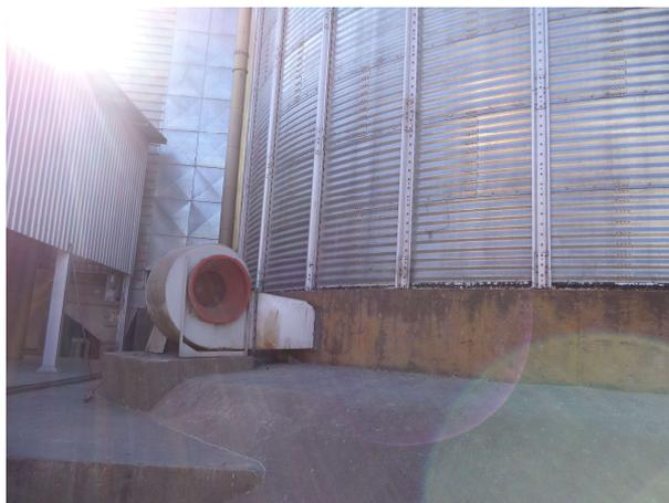
**Figura 34:** Observar exaustor do silo de armazenagem de grãos
