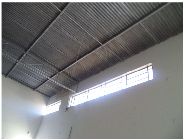
Figura 06: Observar telhado metálico e janelas
