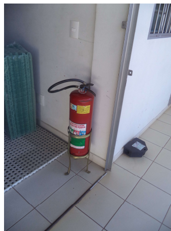
Figura 04: Observar presença de extintor de incêndio e de porta-iscas para roedores
