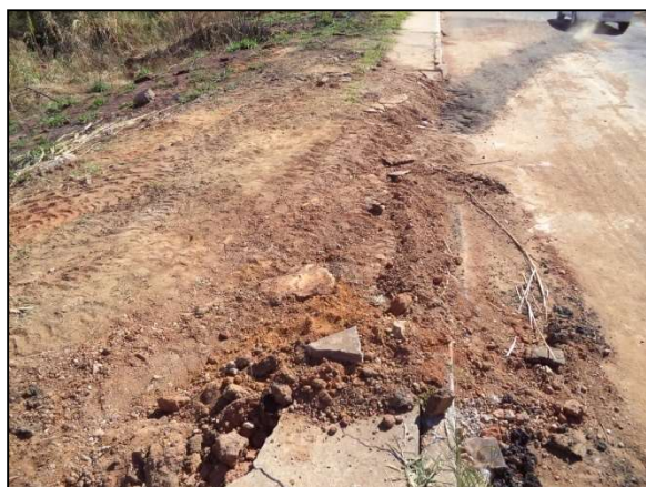
Foto 03 – Início da intervenção em APP
