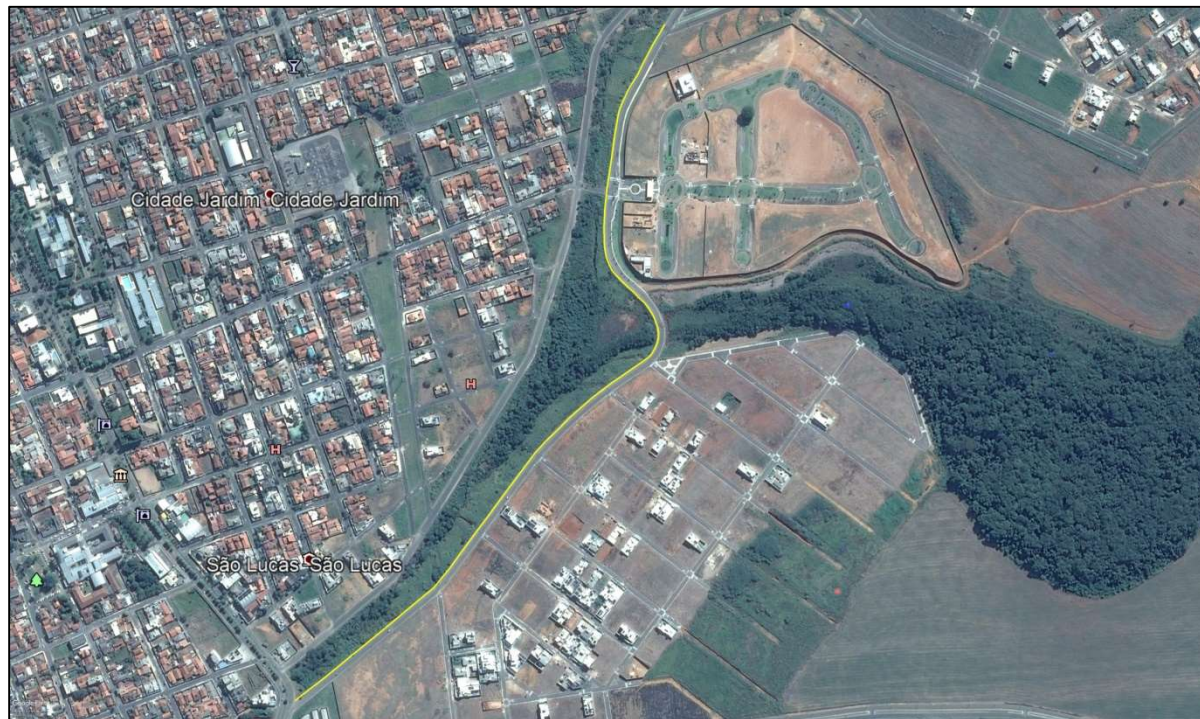
Figura 01: Vista aérea da intervenção. Fonte: Google Earth 2017.
