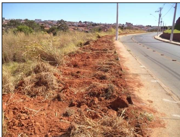
Foto 02 – Intervenção em APP
