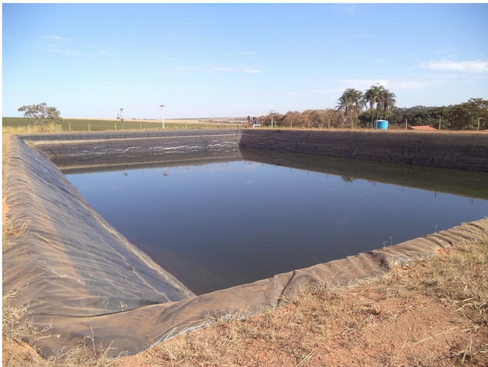
**Figura 05:** Piscinão cercado e impermeabilizado
