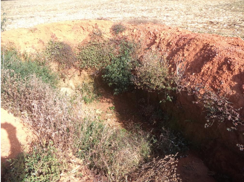
**Figura 03:** Bacia de contenção de água pluvial
