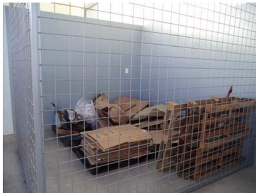
**Figura 11:** Armazenamento provisório de resíduos sólidos em área cercada, impermeabilizada e coberta
