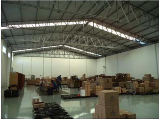
**Figura 03:** Galpão de trabalho, observar telhas translúcidas no telhado
